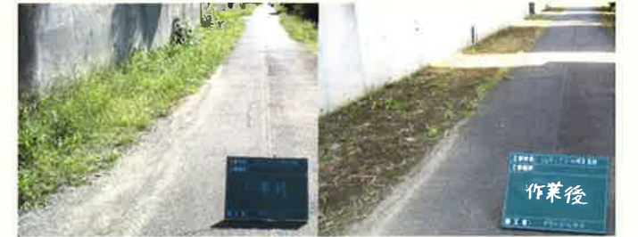
（左：作業前の状態 右：作業後の状態）
